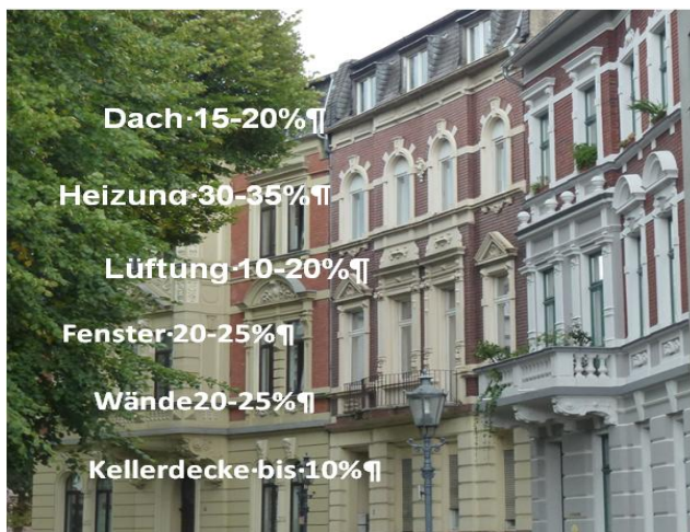
Häufige Wärmeverluste bei Altbauten Foto: Öko-Zentrum NRW
